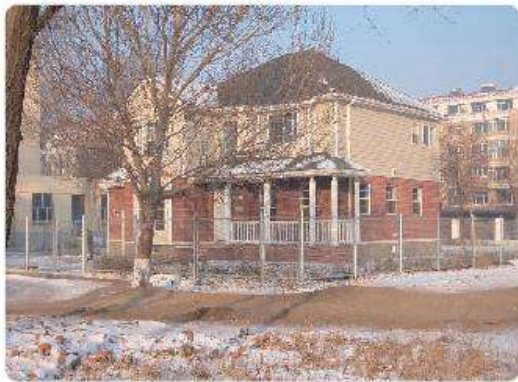
哈尔滨工业大学二校区内 轻型木结构住宅外观照片
