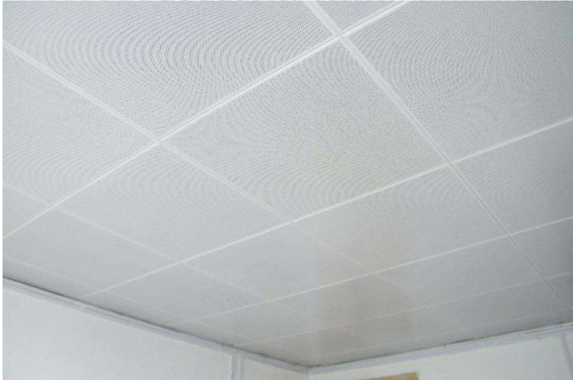
空气载能辐射空调系统 The terminal of ACERS
