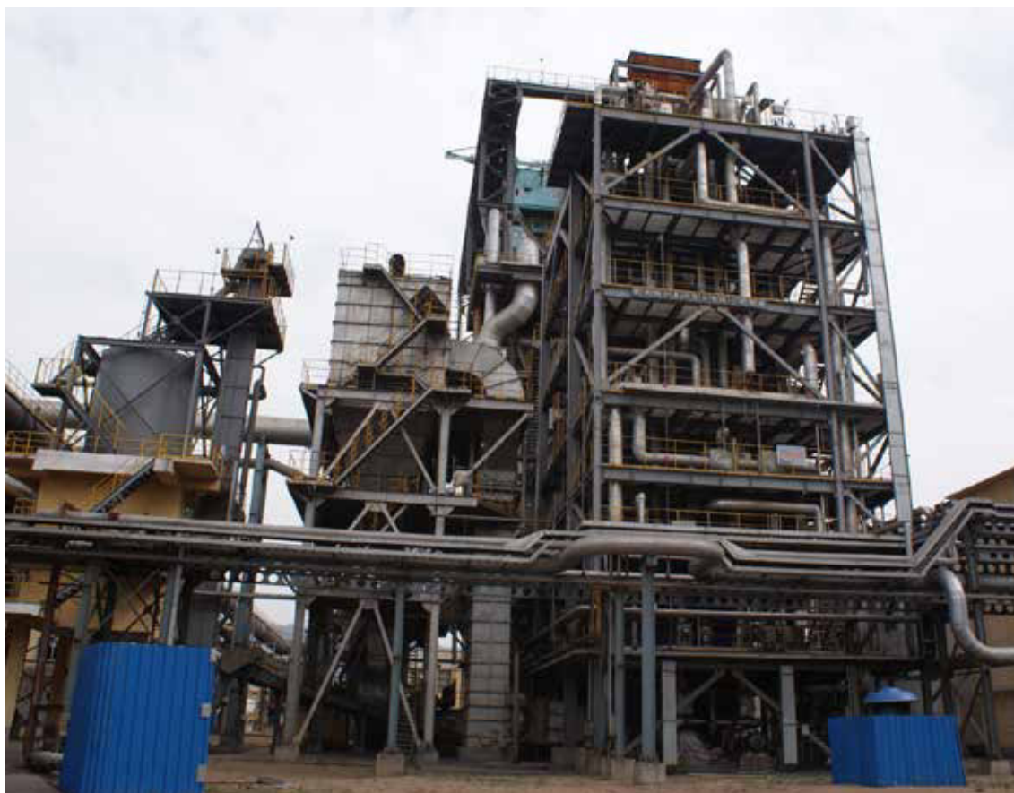
CDQ Boiler 干熄焦余热锅炉
